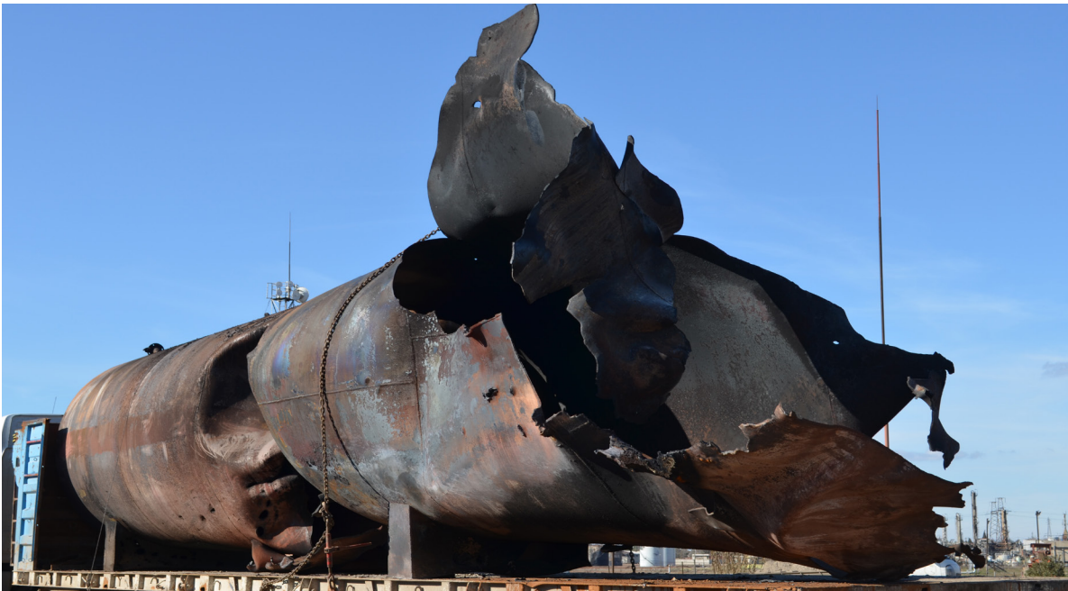
مستودعات الوقود في محطة السويدية للغاز والكهرباء
