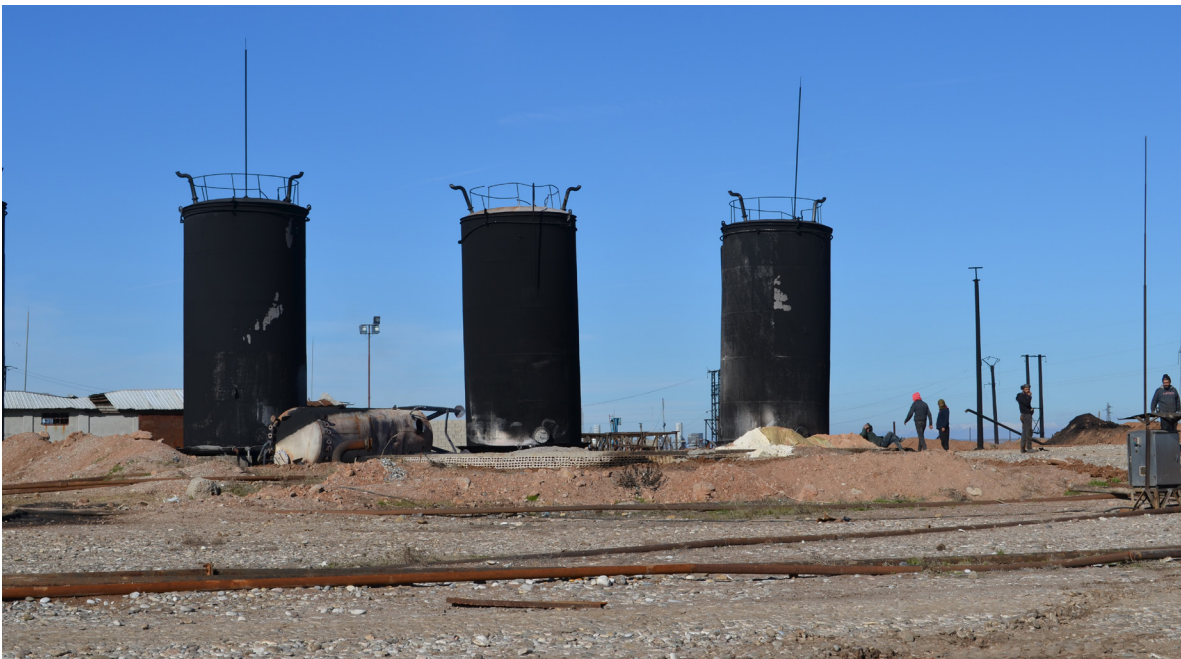
مكامن النفط في منطقة التصفية في محطة السويدية للغاز والكهرباء
