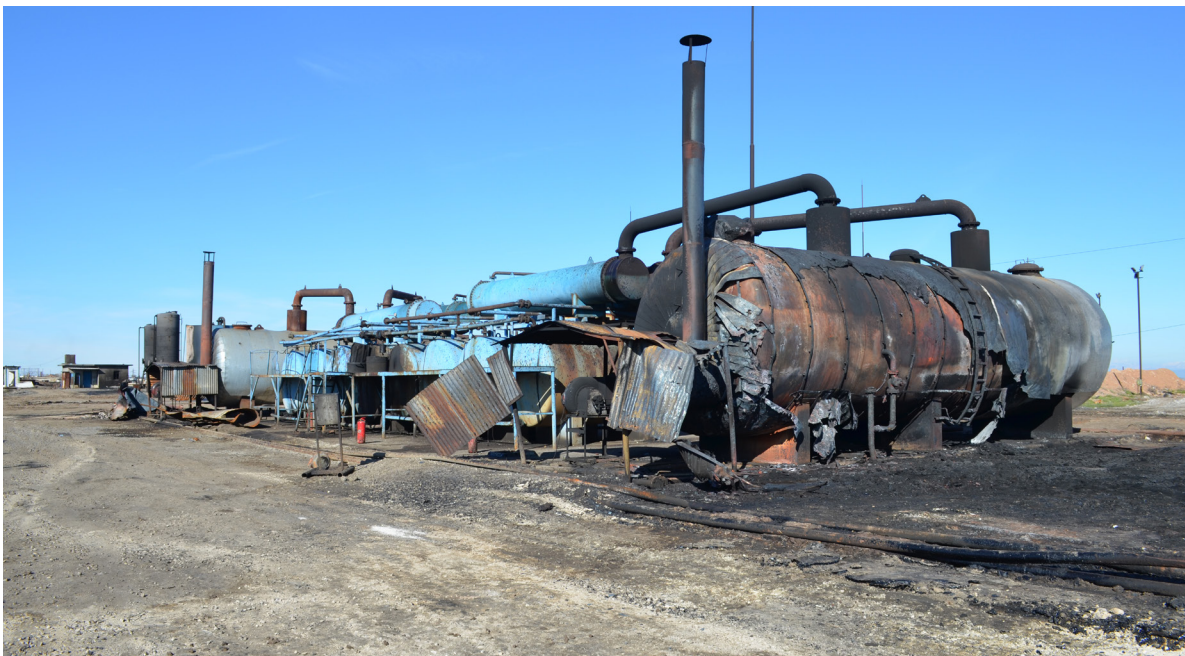
مصافي النفط في محطة السويدية للغاز والكهرباء
