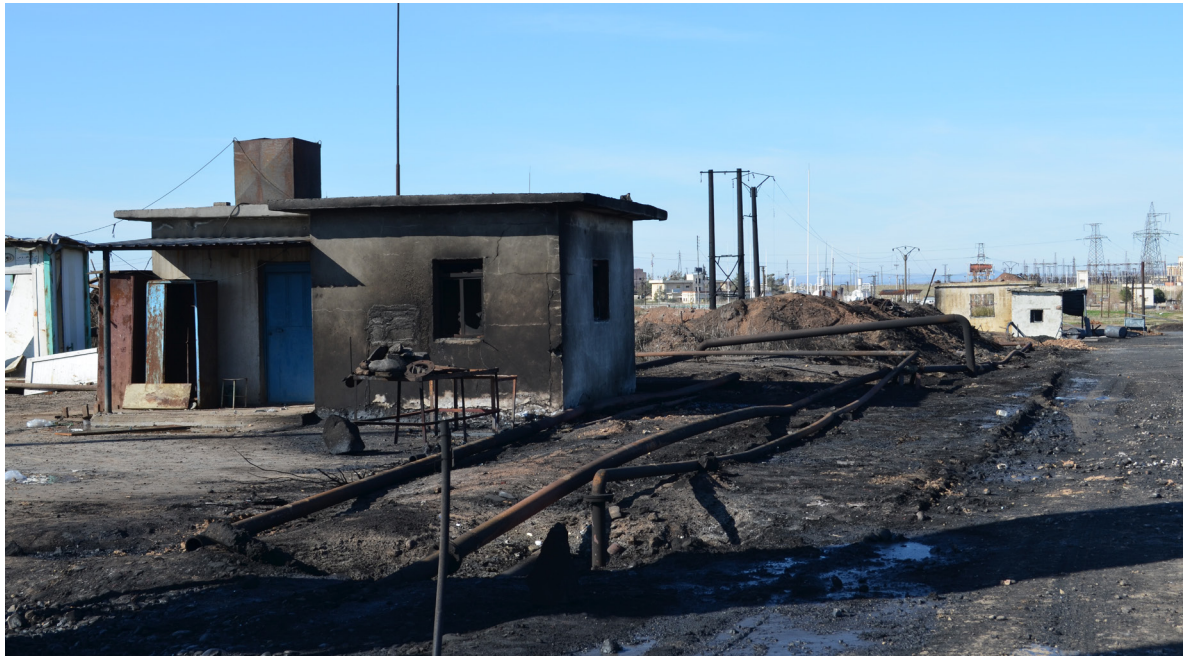
مكتب رجال الإطفاء في منطقة التصفية محطة السويدية للغاز والكهرباء
