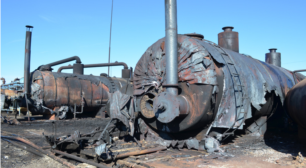
مصافي النفط في محطة السويدية للغاز والكهرباء
