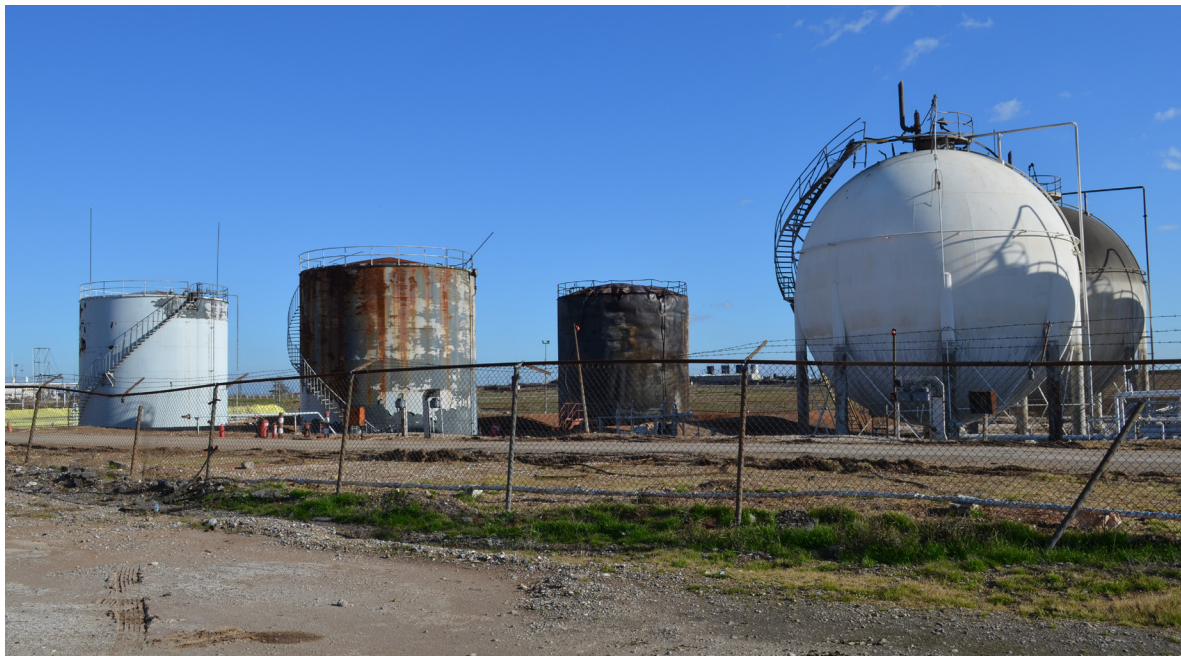
معمل إنتاج الغاز في محطة السويدية للغاز والكهرباء
