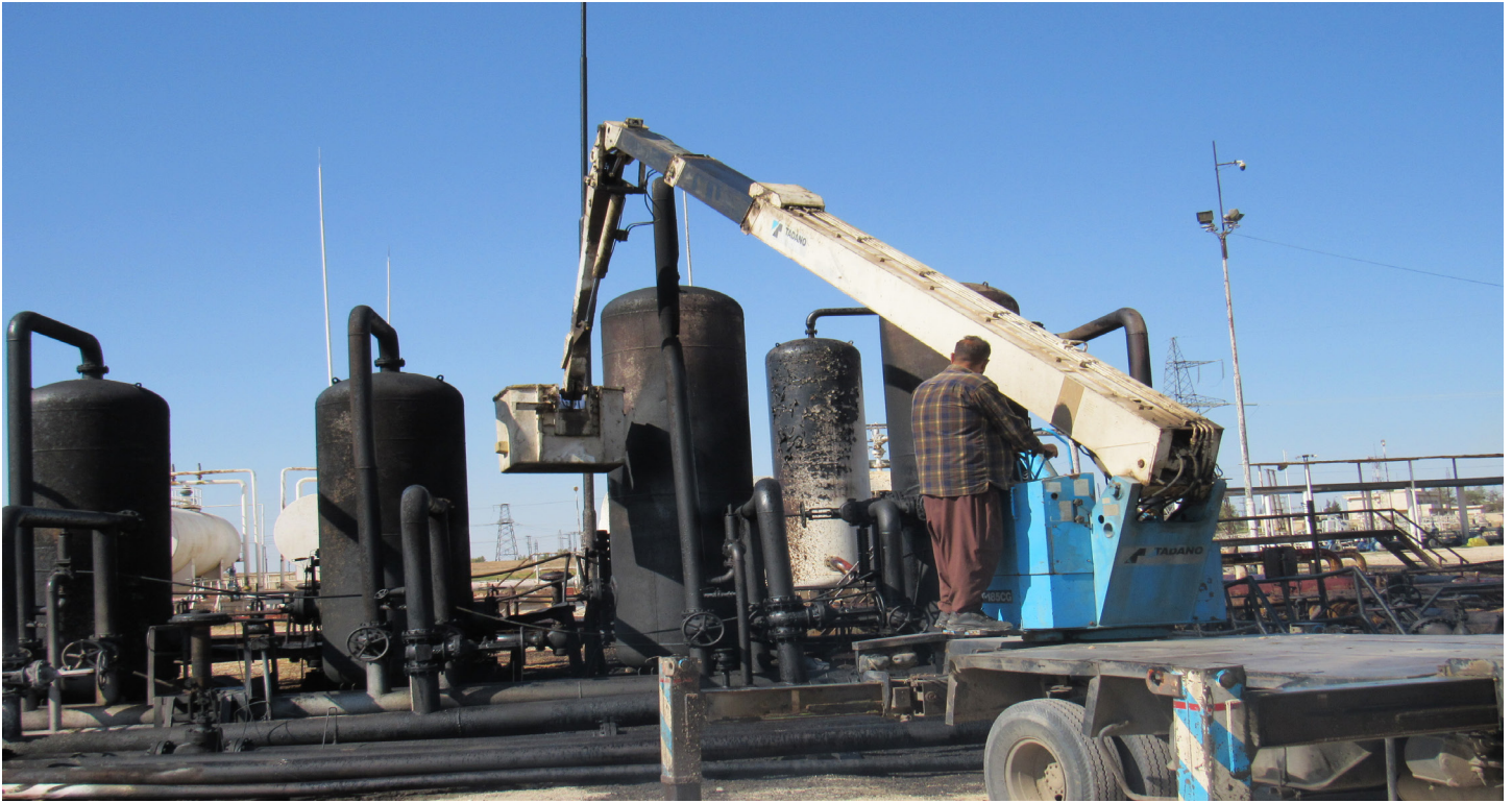
محطة السويدية للغاز والكهرباء - بدأ أعمال الترميم 7 أكتوبر 2023
